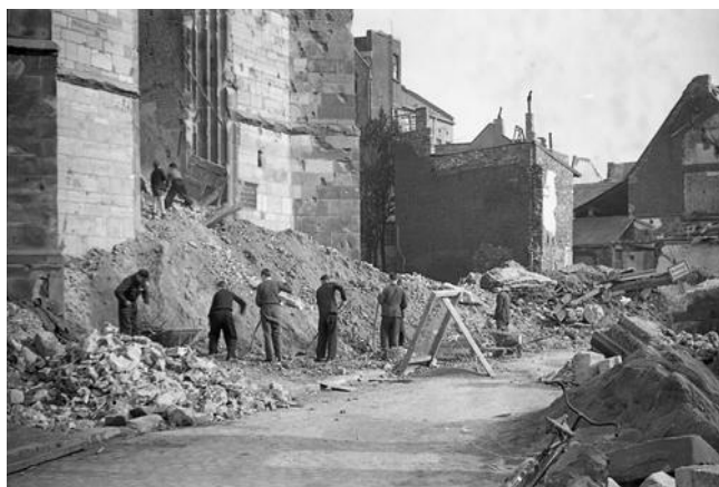
Aufräumarbeiten am Lambertiturm
