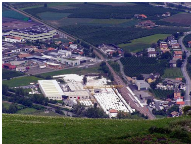
Marmorwerk in Laas
